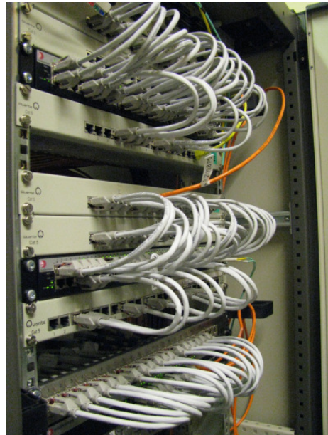
Abbildung 13: „kurze Rangierkabel“
